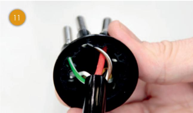
Realice el proceso de crimpar los contactos respetando la asignación de pines de la unidad de contactos.
