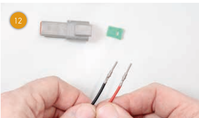
... breng een krimpverbinding tussen de contactpenen en de kabels tot stand...
