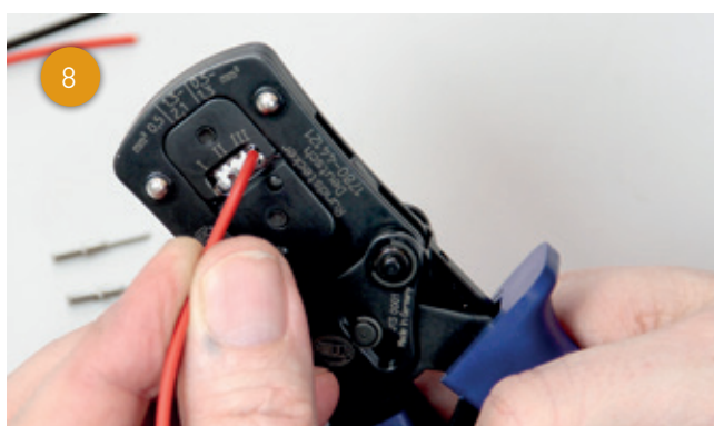
8 ...la douille de contact est sertie avec le câble.
